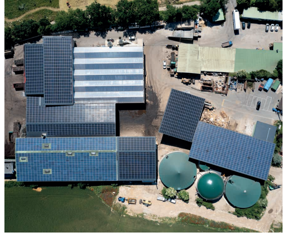
Ecorecyclage, à Lavigny, transforme les déchets organiques de près de 70 communes vaudoises en biogaz. Ce gaz renouvelable est injecté dans le réseau gazier.
